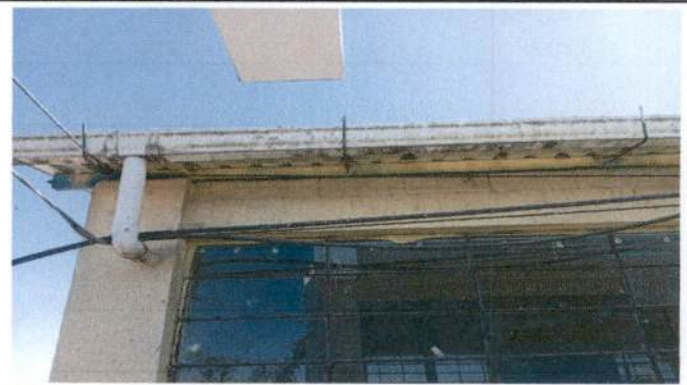
Foto 2: Sustitución de canal PVC
