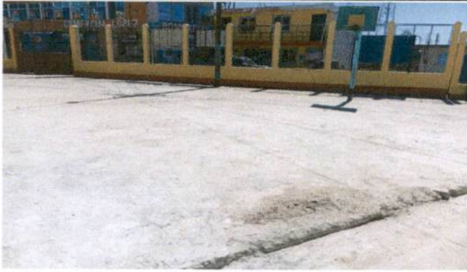
Foto 1: Reparación de piso de torta de concreto
