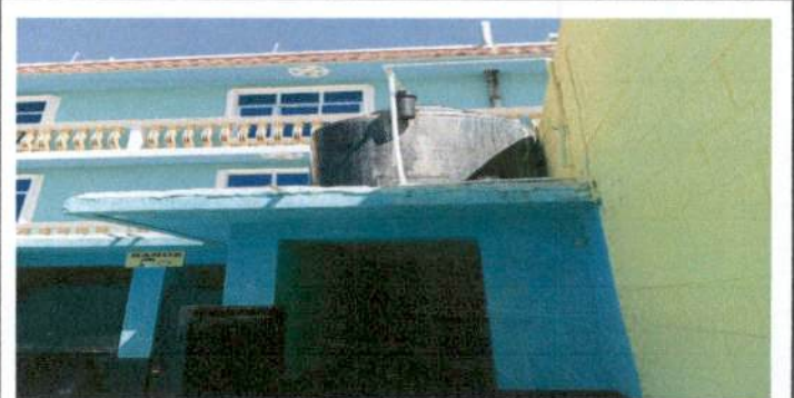
Foto 6: Sustitución de depósito de agua 1000 lt
