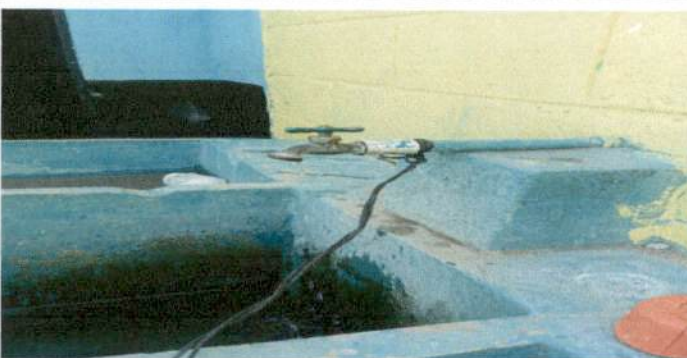
Foto 5: Sustitución de llave de chorro
