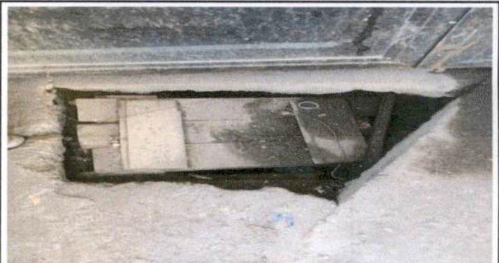
Foto 4: Sustitución de caja de contador
