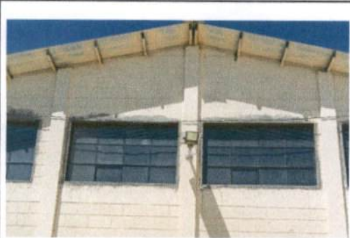
Foto 7: Fabricación e instalación de balcones de hierro en ventana
