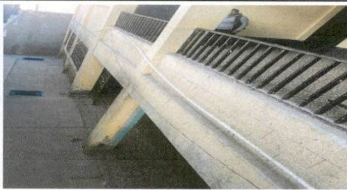
Foto 3: Sustitución de tubería línea principal
