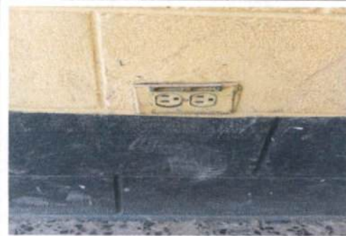
Foto 9: sustitución de tomacorrientes dobles
